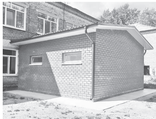
В Пелевинской школе отремонтирован туалет.
