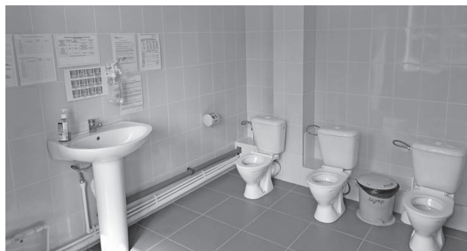
В д/с «Рябинушка» отремонтированы умывальные комнаты.
